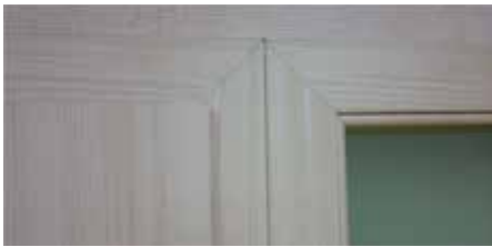
З'єднання Фрамуги Verto-FIT з дверною коробкою Verto-FIT
