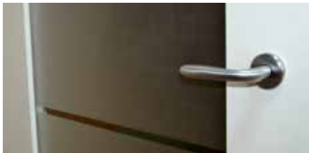
Скло матове з прозорим малюнком, встановлене без обкладу (в паз складових полотен)
